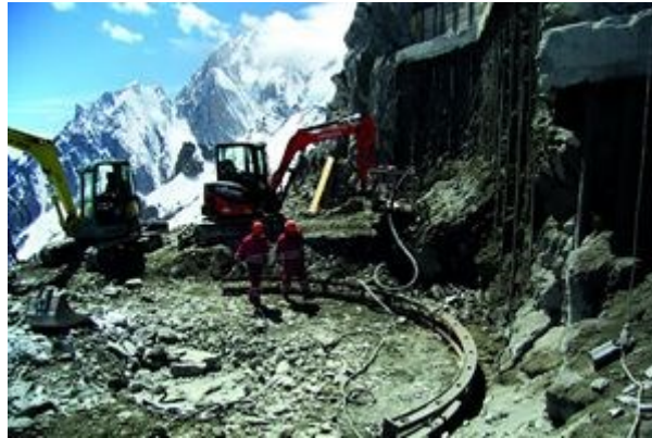
Il cantiere sul Bianco (Foto Funivie Monte Bianco)
